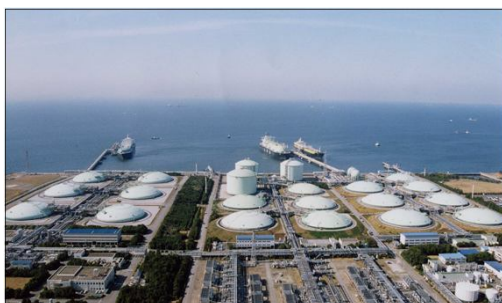
Tokyo LNG terminal
